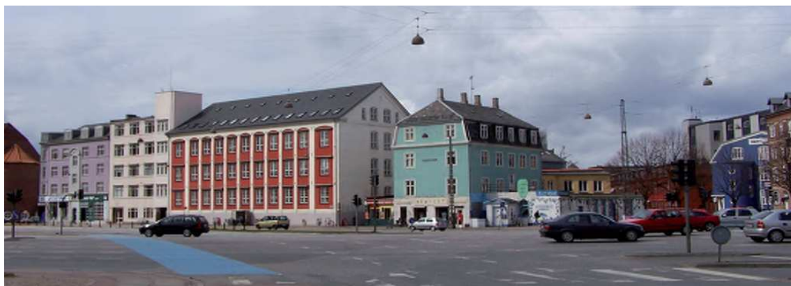
Hjørnet af Jagtvej og Aldersrogade set fra den anden side af Vibenshus Runddel. Den nuværende bebyggelse giver stedet en lavintensiv og opløst karakter.
