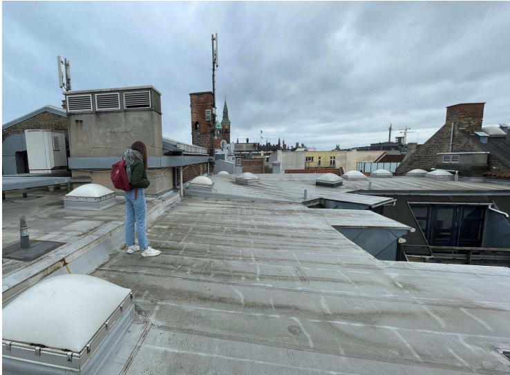
Billede fra eksisterende tag med gummimembran
