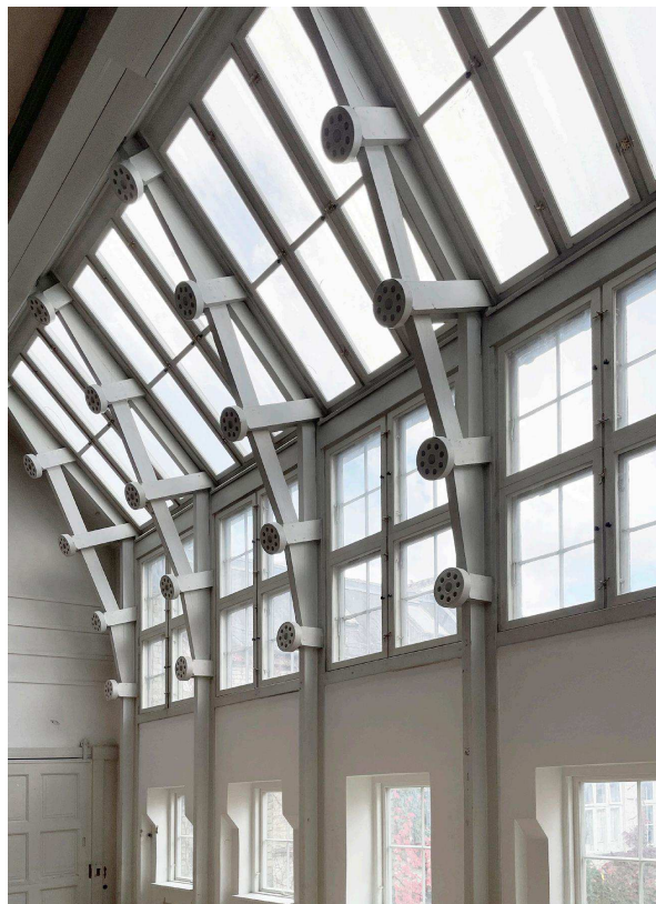
Fotografi: Trækonstruktioner i gymnastiksalens facade
