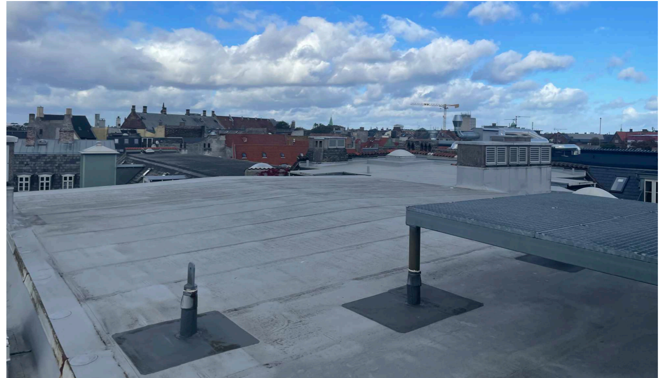
Foto af eksisterende tagdækning på Grundtvigs Hus
