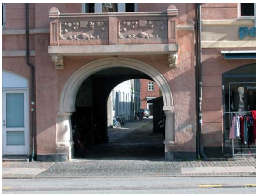
Porten Amagerbrogade 155 fører ind til passagen (Keplersgade).
