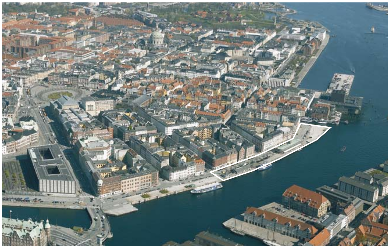
Luftfoto af lokalplanområdet (vist med hvid ramme) og omgivelser set mod nordvest. (JW Luftfoto april 2007).
