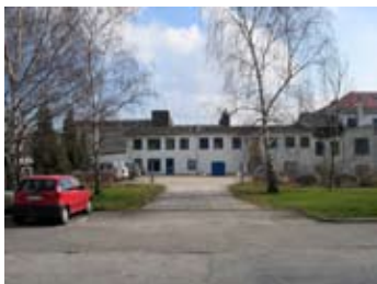
Eksisterende indkørsel fra Kobbelvænget.
