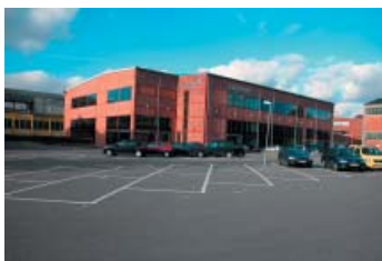
Fitnesscentret Equinox er indrettet i en nyligt ombygget industribygning, hvor de røde teglsten og rødmaledede lodrette og vandrette jernbånd er bevaret. De nye store vindues-partier er indpasset i den oprindelige opdeling af facaden.
