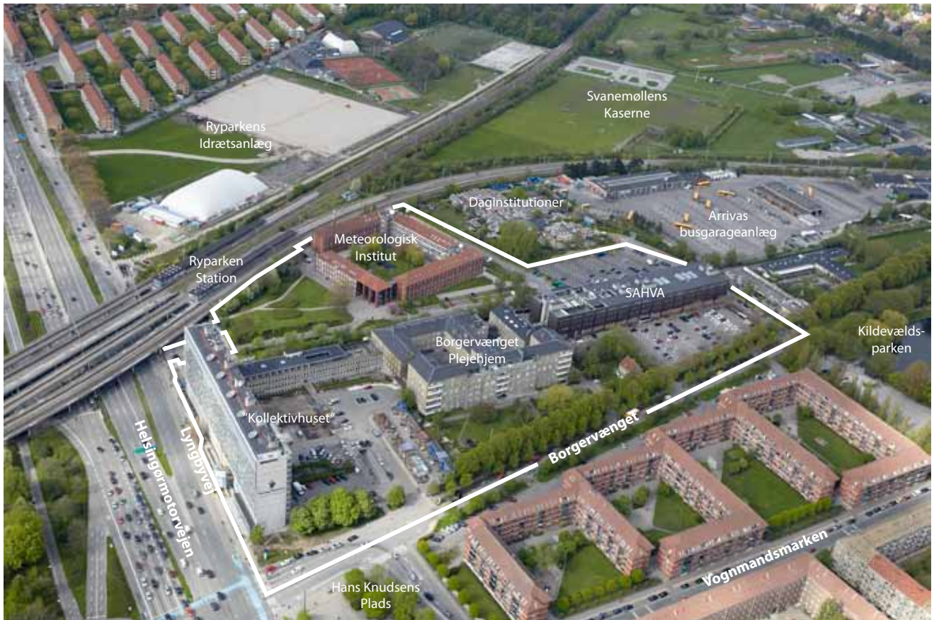
Luftfoto af området med lokalplangrænsen vist med hvid streg
