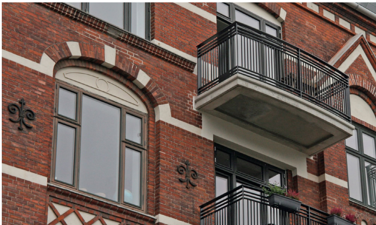
Sankelmarksgade. Buen over vinduet er fjernet men der er skabt en god helhedsvirkning ved at lade det lyse dekorative bånd skabe en naturlig overgang. Betonbundens stoflighed og fine detaljering harmonerer med facaden.
