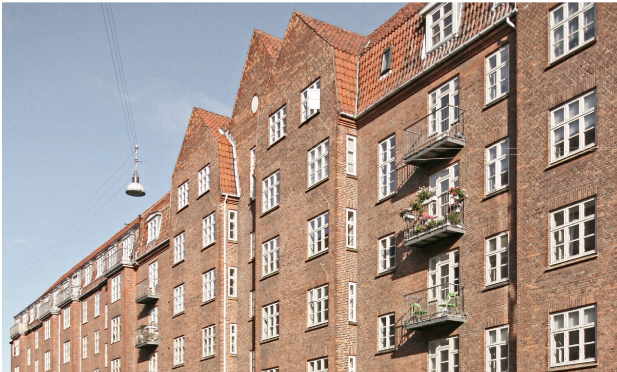
Ved Kløvermarken. Husets symmetri respekteres og understreges af de to rækker altaner, der tilpasser sig facadespringene i dybden.
