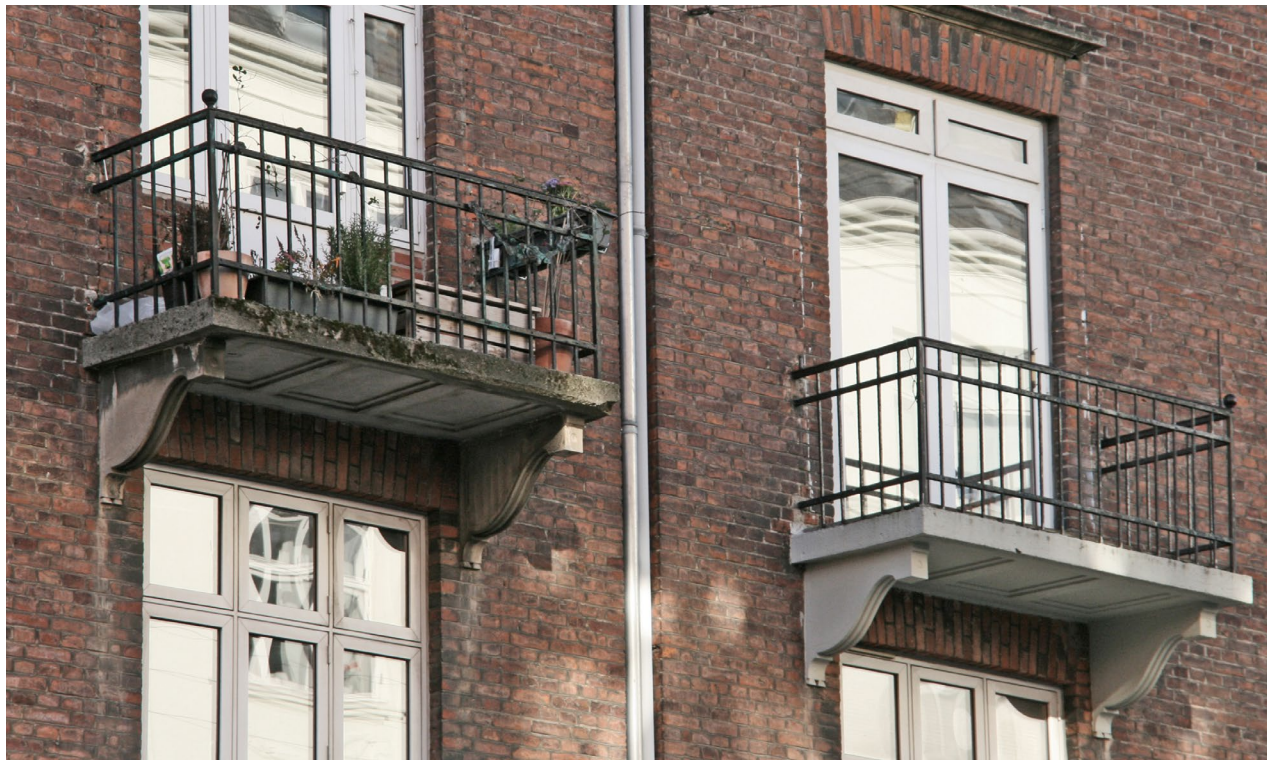
Sommerstedgade. Restaureret oprindelig altan.
