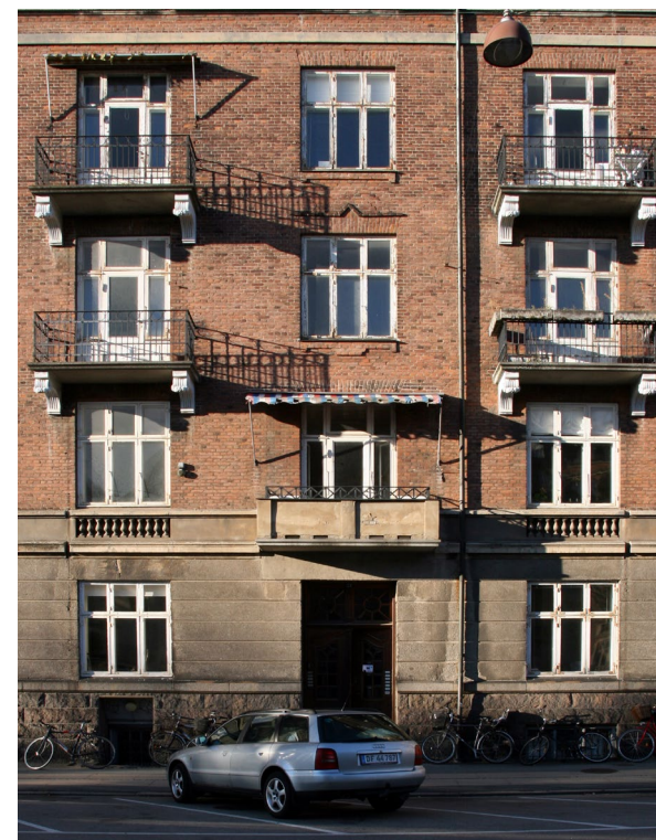
Kastelvej. Oprindelige altaner i forskellige udformninger, der forholder sig til deres placering på facaden.
