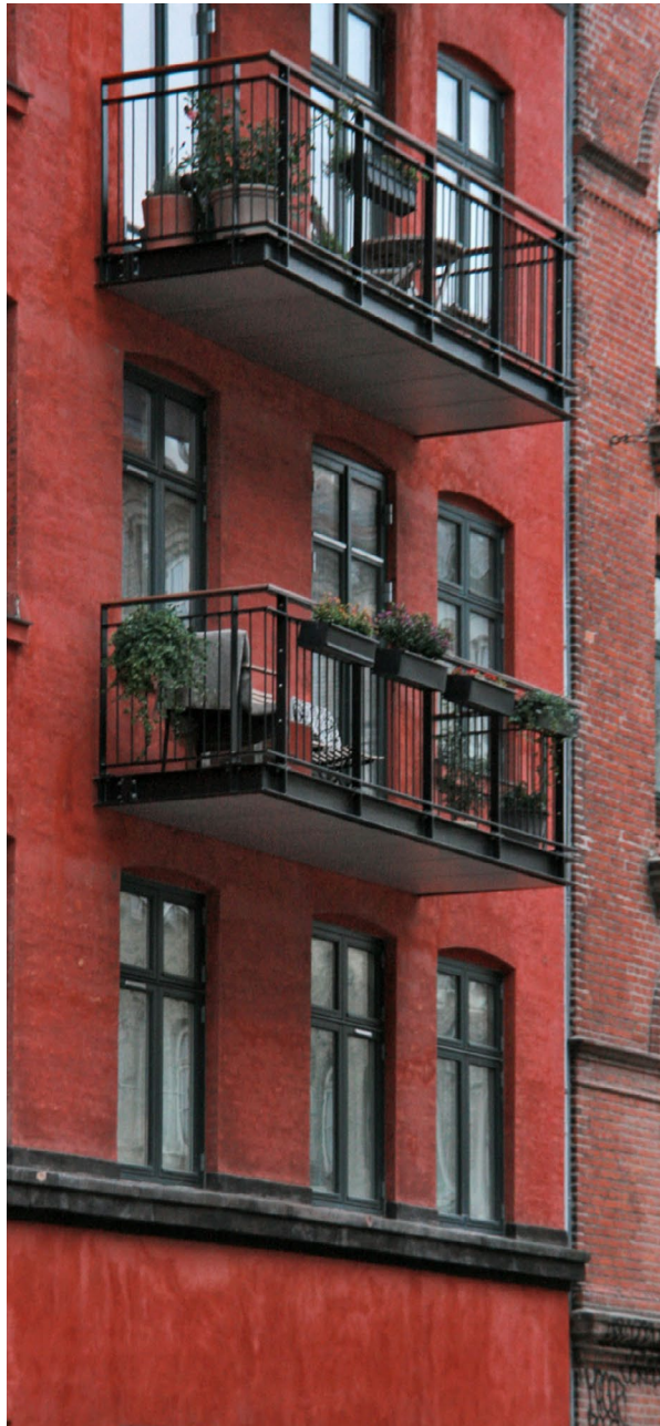
Ravnsborg Tværgade. Sorte altaner der matcher farven på vinduer og gesimsbånd. De spinkle værn lader facadens farve og stoflighed skinne igennem.
