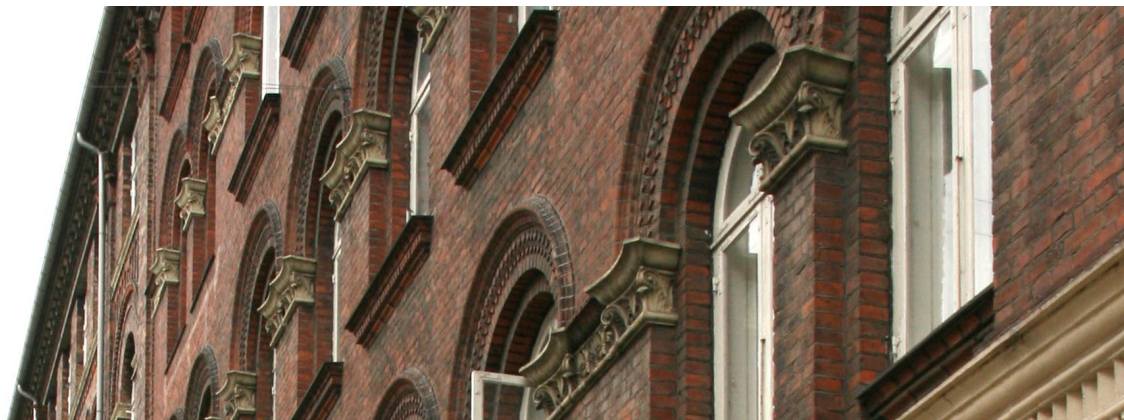
Holbergsgade. Detaljerig muret facade med rundbuer
