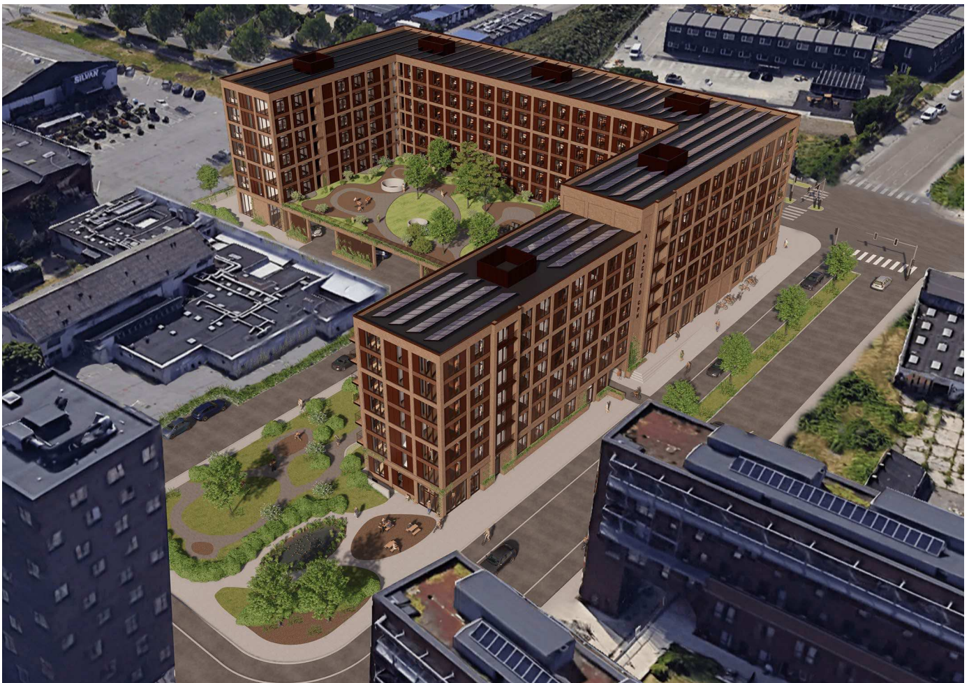
Visualisering, der viser et eksempel på et nybyggeri i overensstemmelse med lokalplanen. På illustrationen ses opholdsarealet på taget af plinten, der rummer bil og cykelparkering. Illustration: Novaform Arkitekter.
