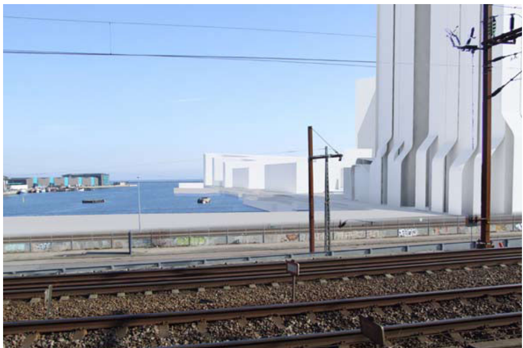
Figur 7-7 Fotostandpunkt 6, set fra Nordhavn St. syd
