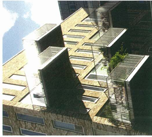
Dyb udenpå liggende altaner på brun teglfacade
