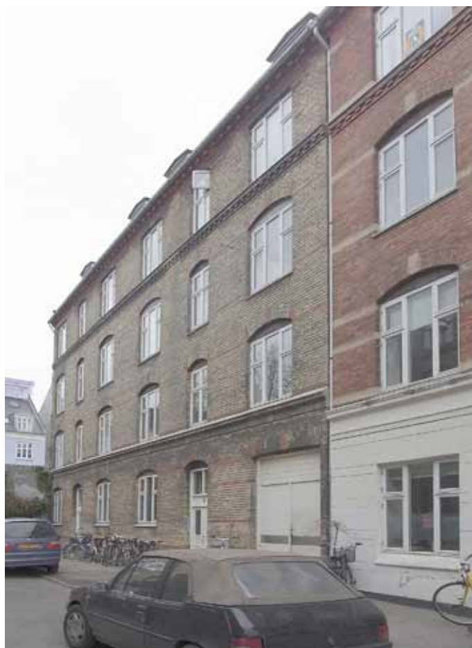
Udsnit af gadefacade mod blind vej
