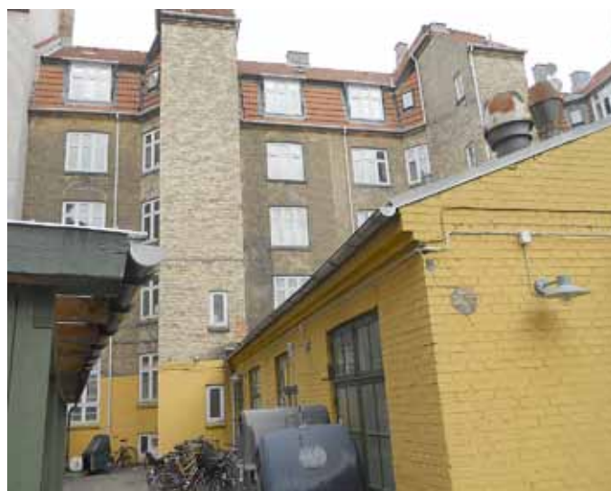
Facade mod gård med tilbygning
