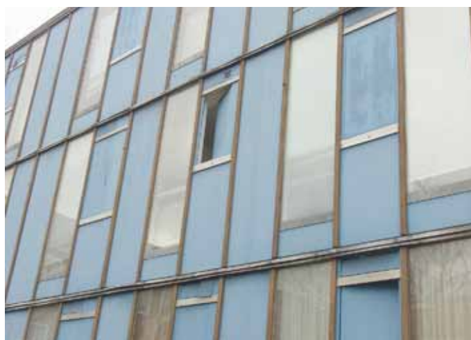
Facadeudsnit med uisolerede trælåger
