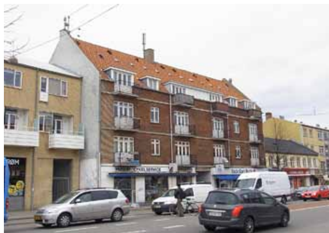
Gavl og gadefacade
