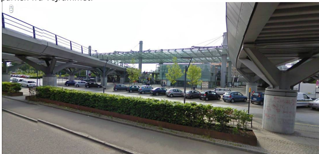
Figur 8: Flintholm St. som indslag i parken. Hække afgrænser park og station mod vejen. Stationsbygning og overdækning danner baggrund for byrummet set fra Grøndals Parkvej
