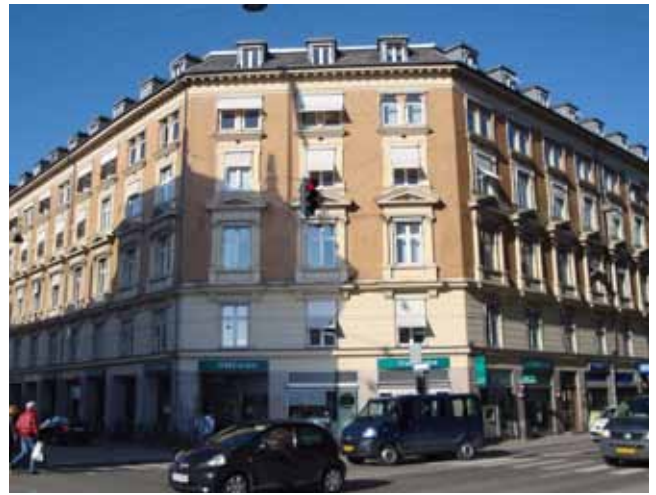
Hjørneejendommen Gothersgade/Store Kongensgade er et eksempel på Type 4.
