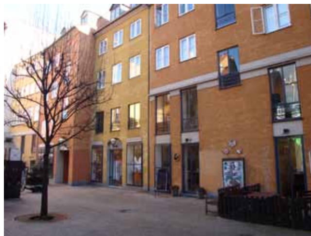
Butiksfacade mod gården Store Kongensgade 5B-19B.
