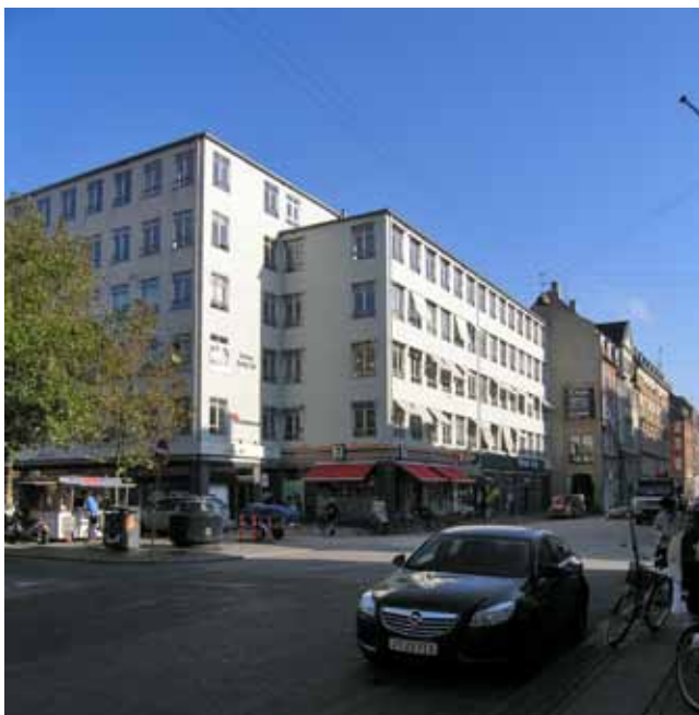
"Borgergadehus". Eksisterende forhold.
