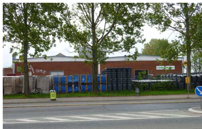
Bygningen set fra Kløvermarksvej
