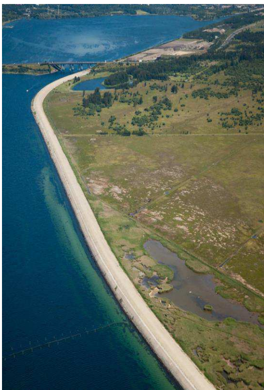
Diget mellem Kalvebodbroen og Kongelunden, der er forhøjet fra 2009 til 2012. Diget står nu i kote 5,9 m og vil kunne være med til at beskytte København mod stormflod fra syd. Men ikke i sin nuværende form, da en stormflod i dag vil kunne presse vand omkring diget ved Kongelunden eller videre ind af Kalveboderne. (Foto: KMC Nordhavn)
