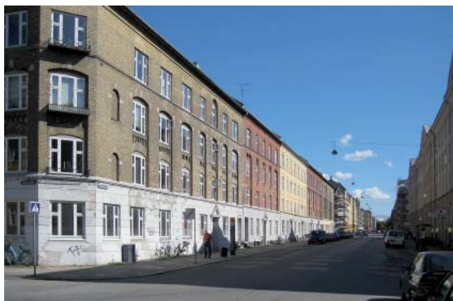
Mange bygninger i Skt. Kjelds Kvarter Nord er fysisk nedslidte
