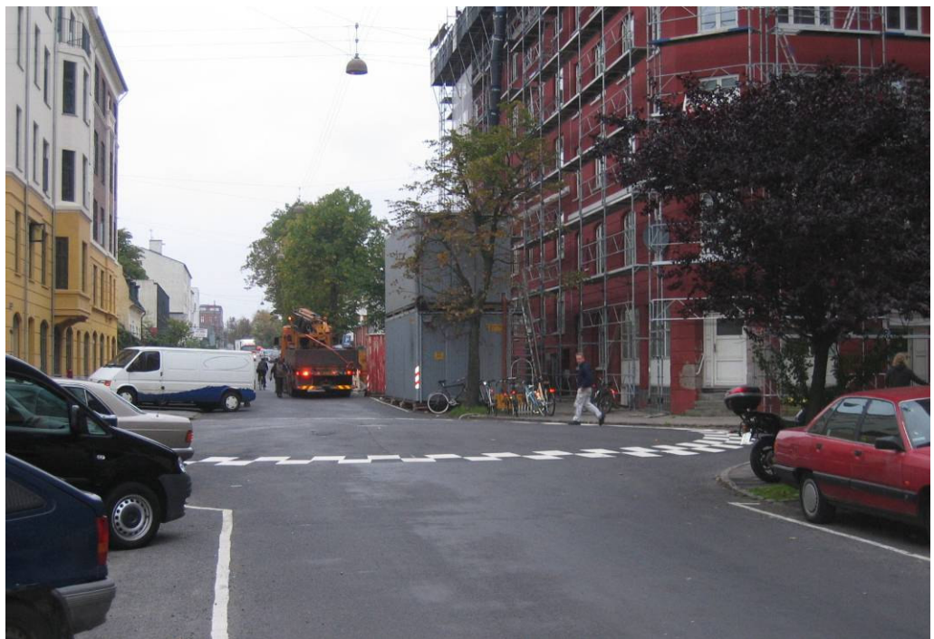
Utraditionel anvendelse af kuppelbump til sikring af firvejskryds med højrevigepligt
