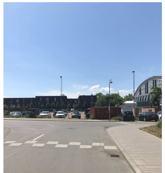
Billedet viser nordskellet af matr.nr. 650bt, Christianshavns Kvarter, hvor der etableres botilbud til unge med autisme. I baggrunden ses rækkehusbebyggelse.
