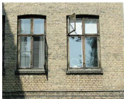
Før 1930: Forskelligt facadeudtryk til gade og gård på Engtoftevej 1-3. Kvaderpuds og balustre til gaden. Blank mur uden dekorationer til gården. Historicisme.
