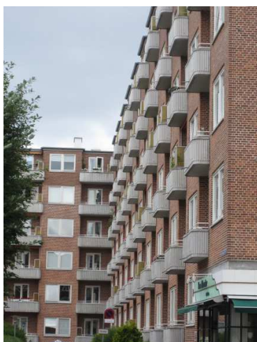
Til venstre: Finsensvej 89-99 med inddeliggende dobbeltaltaner med støbt værn og muret afskærmning. Stokbebyggelse placeret vinkelret på vejen. Til højre: Julius Valentiners Vej 1-11 med påhængte altaner og støbte værn mod et U-formet underum ud til vej.
