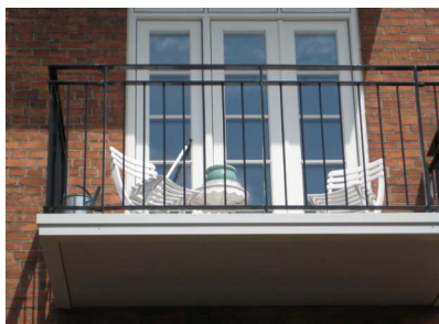
Altanbundens profilering og værnets udformning spiller smukt sammen med dørpartiets profilering. Eksemplet er fra Hattesens Allé 2.
