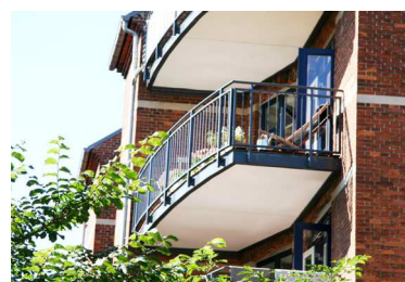
N. J. Fjords Allé 9 med lys mat bund, der ikke sluger meget lys.
