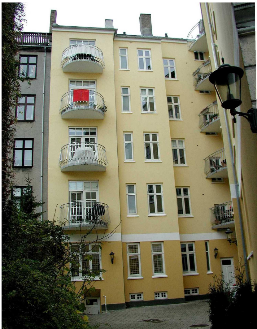
Bülowsvej 48B med nye altaner smukt centreret på både fremtrukket facadeparti og om to-fløjet dørparti.
