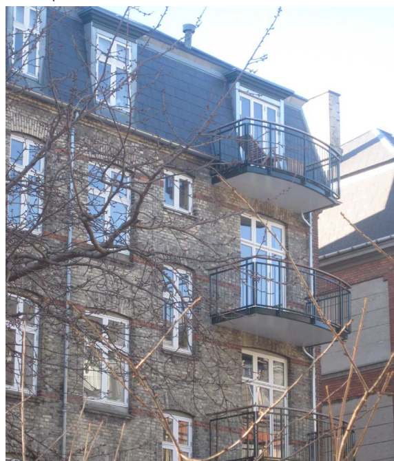
Altaner i kolonne med lidt smallere altan i mansardtaget øverst på L. I. Brandes Allé 15-17.
