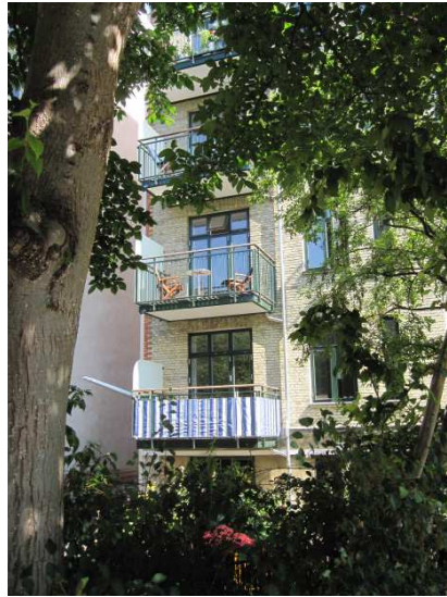
Eksempler på tidens standardaltaner på gårdfacade. Til venstre Folkvarsvej 11-13. Til højre Hostrupsvej 6.
