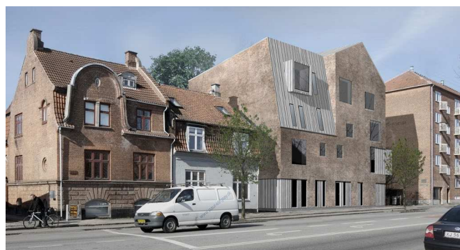
Facade mod Frederikssundsvej (Cornelius + Vøge)
