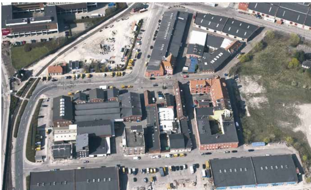
Luftfoto af den vestlige del af Århusgadekvarteret i dag. Et blandet og forskelligartet erhvervsområde
