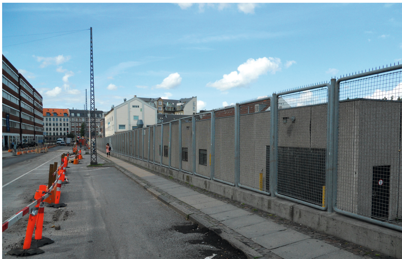
Lokalplanområdet set fra sydlige del af Skelbækgade. Den lave bygning rummer lager. Sammenlign. med projektillustrationen s. 4 øverst
