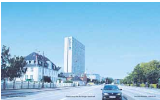
Eksisterende forhold set fra Amager Boulevard.
