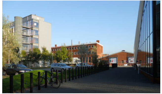
Et kig fra Metropoliskolens udeareal. De to røde bygninger ved Rådmandsgade forudsættes nedrevet. Industrikollegiet ses til venstre.
