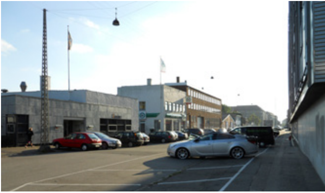
Et kig ad Rådmandsgade mod lokalplanområdet, hvor erhvervsbygningerne på venstre side af gaden forudsættes nedrevet. Industrikollegiet ses helt til højre i billedet.
