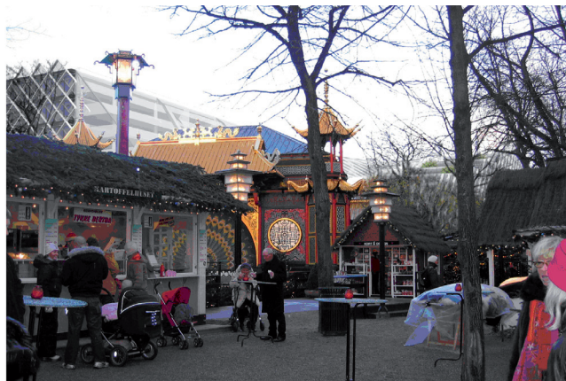
Pantomimeteatret - efter. Den nye facade er i bedre dialog med Tivoli's glasarkitektur.
