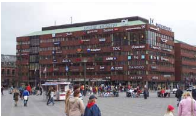
Industriens Hus, opført 1978-80. (Arkitekt Erik Møller).
