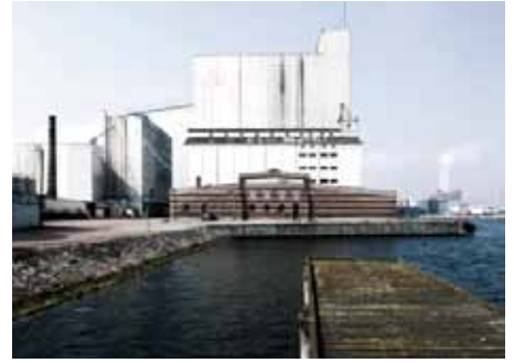
Indre Nordhavn i dag - siloer ved kajkant
