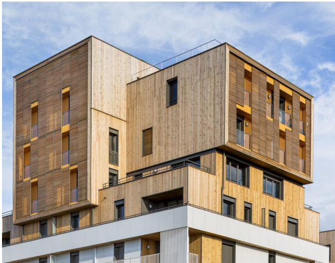
Reference der viser eksempel på facade med træbeklædning. Foto af Ameller Dubois Architects
