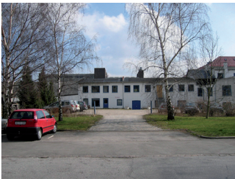
Eksisterende indkørsel fra Kobbelvænget.
