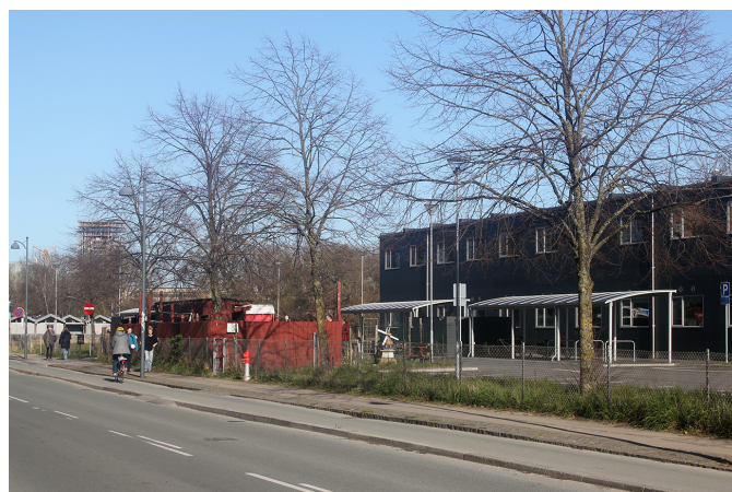
Lokalplanområdet set fra Artillerivej mod nord med den midlertidige daginstitution. Det sociale værested i den røde barak skal flyttes længere mod nord.
