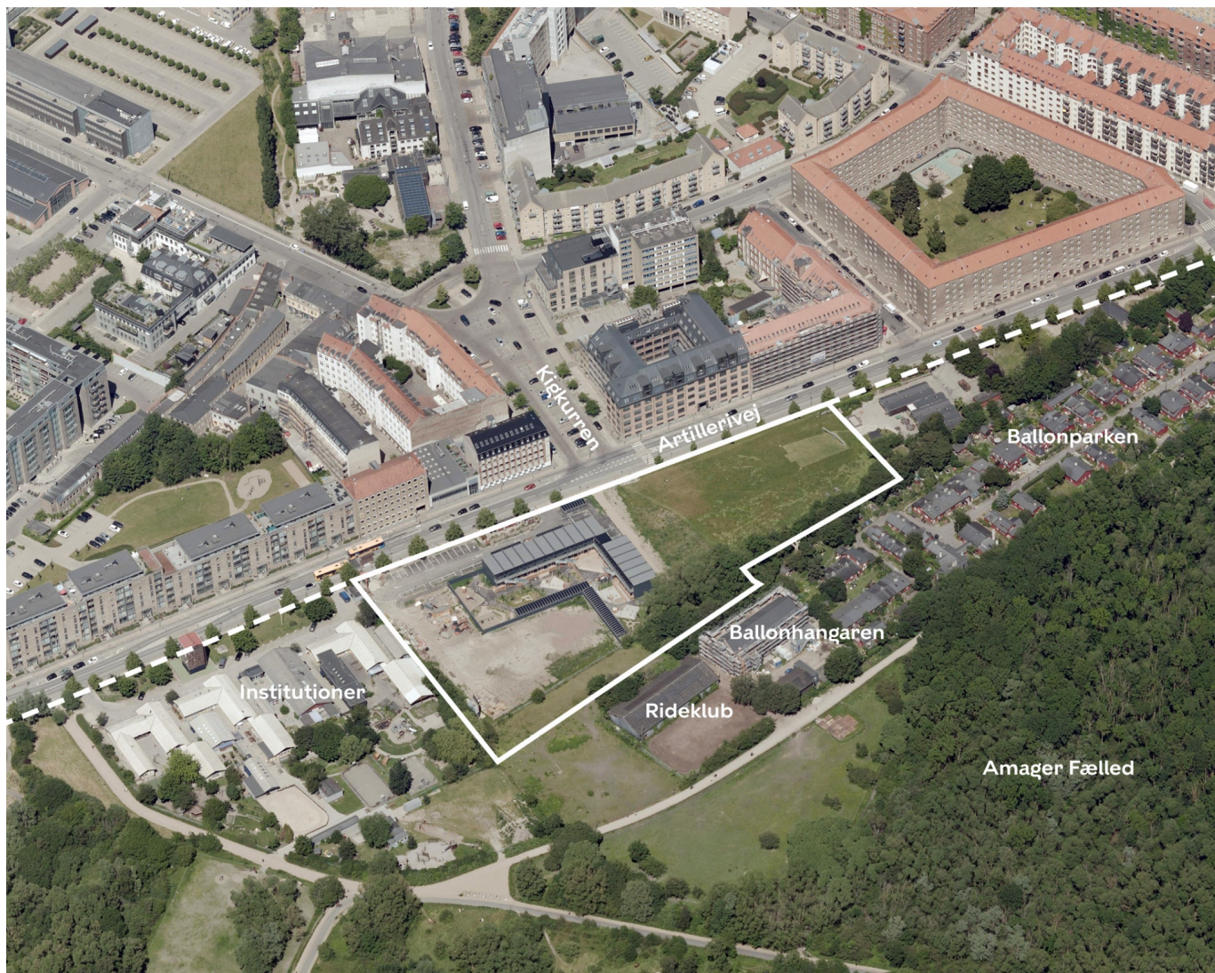
Området set mod nordvest. Lokalplanområdet er indtegnet med hvid linje, og de vigtigste gader og bygninger er navngivet. Luftfoto: Kortforsyningen, 2019.
