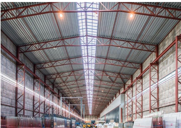
1.5 Eksisterende stålstruktur og ovenlys i Armeringshallen.
