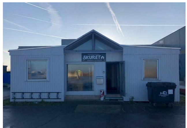
4.1 Pensionistforeningen i havnen, midlertidigt pavillonbyggeri.
