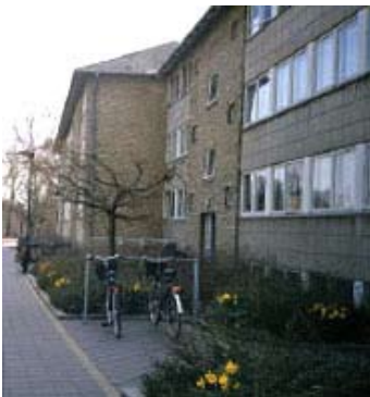
Eksisterende indgangsparti med cykelparkering.
