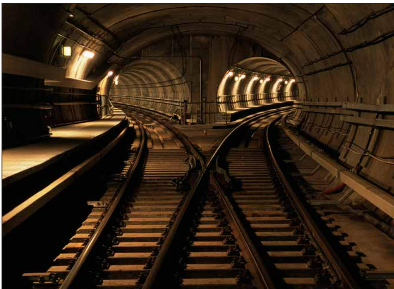
Afgrening på den eksisterende Metro
