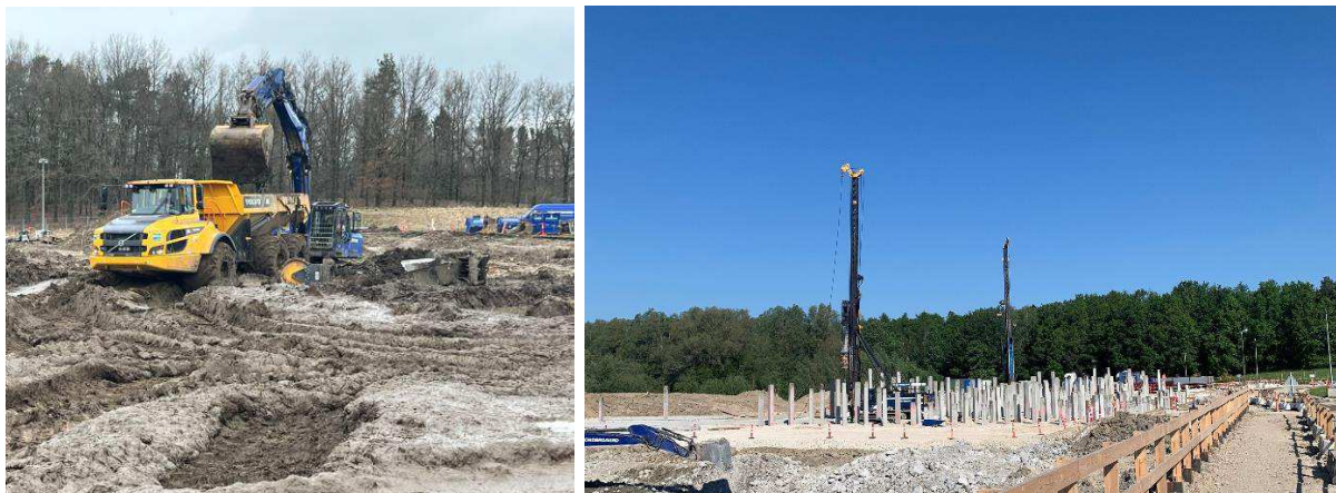
Figur 2 Foto af opstart i den våde vinter og foto af ramning af 1.800 pæle
