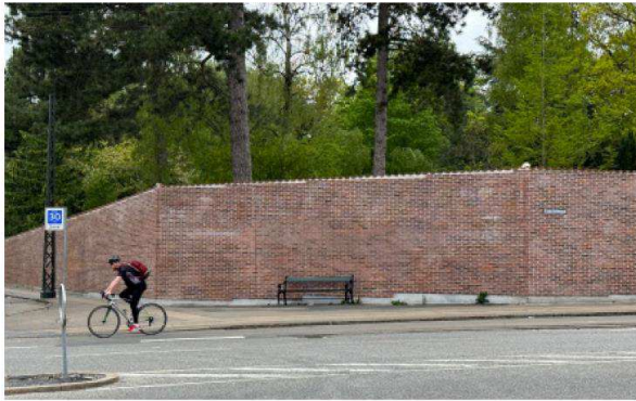
Eksisterende forhold ved hjørne: muren brydes ned
