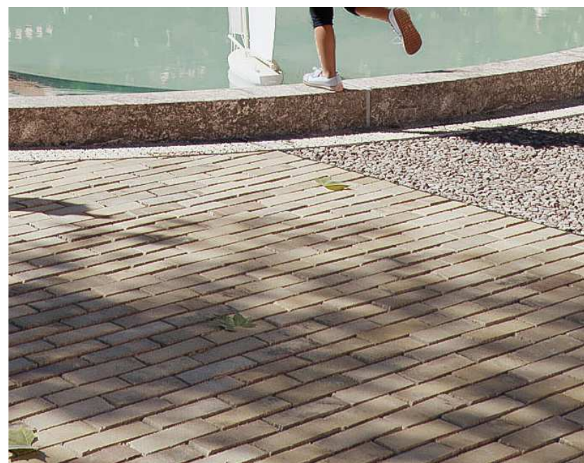
Ny klinkebelægning og granitkant ved vandspejl
