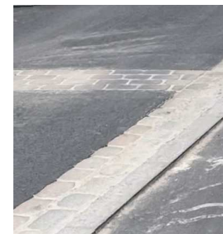
Asfalt og kantsten
