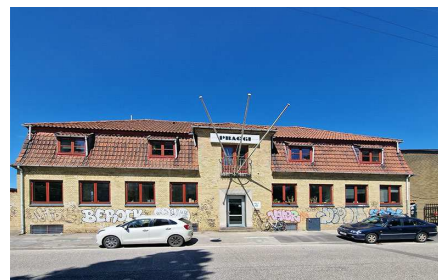
Hovedbygningen på Siljengade 61, der foreslås udpeget som bevaringsværdig.
