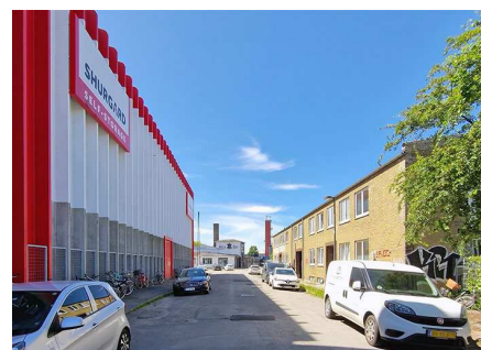
Siljengade med hovedbygningen på Laplands-gade 6 i baggrunden, der i Byens Sjæl er udpeget som en del af dommerpanelets favoritfelt.
