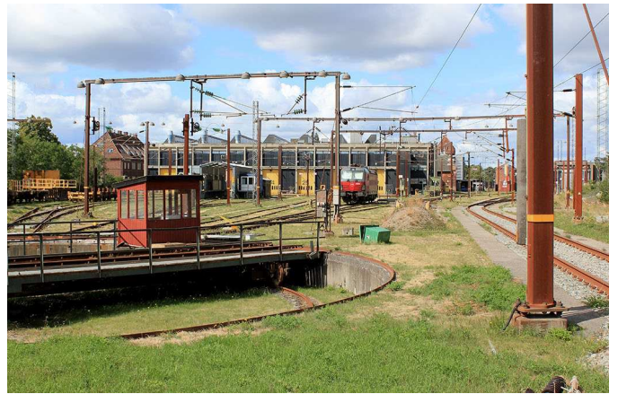
Drejeskiven er et af de bevaringsværdige tekniske anlæg, der er karakteristisk for området.
