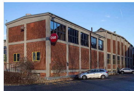
19. og 20. Værksted og Eftersynshal.
