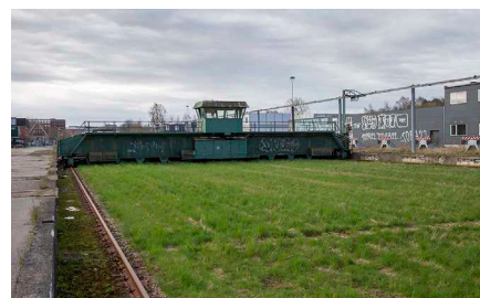
29. Skydebroanlæg, broer, førerhus og spor.
