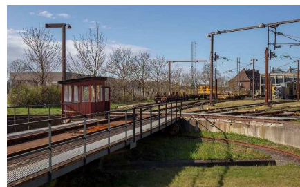
28. Drejeskiveanlæg, bro, førerhus og spor.
