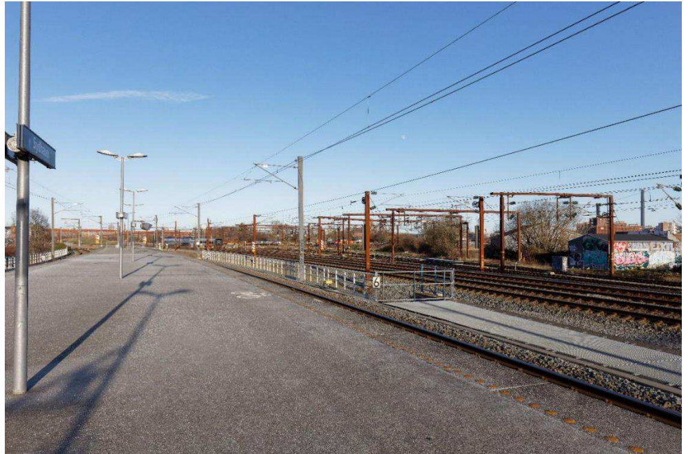
Figur 7-22 Punkt 10a – Sydhavn Station. Eksisterende forhold. (COWI)
