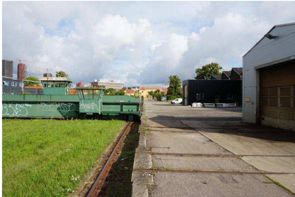
Figur 6-18 Skydebroanlægget set fra syd. Vognværkstedet ses til højre i billedet. Foto Cobe.
