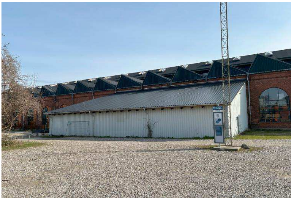
Figur 5-88 Påbygning på Lokomotivværkstedets facade, set fra vest, som kan fjernes. Påbygningen vender ud mod den centrale plads. Foto COBE.
