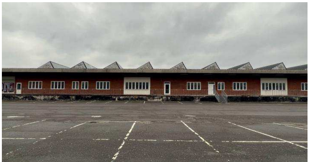
Figur 4-5 Toldkammerbygningen i syd med læsserampe og karakteristisk shedtag (Foto: Cobe)
