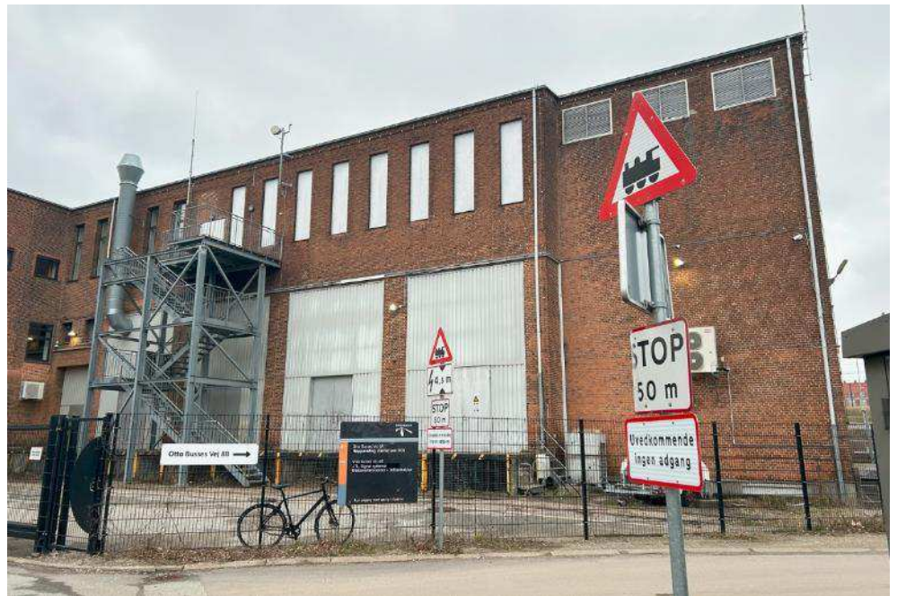
Figur 5-18 Omformerstationen set fra sydøst. Foto COWI 2024.
