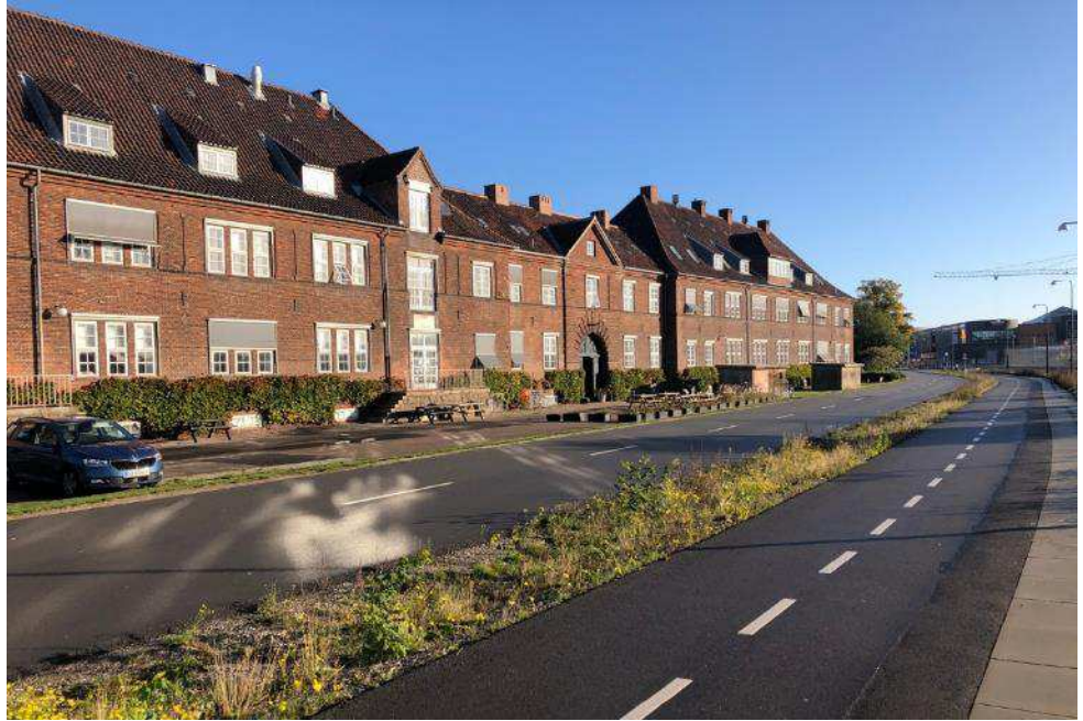
Figur 5-126 Kontor- og administrationsbygning set fra sydvest mod øst. Foto Cobe.
