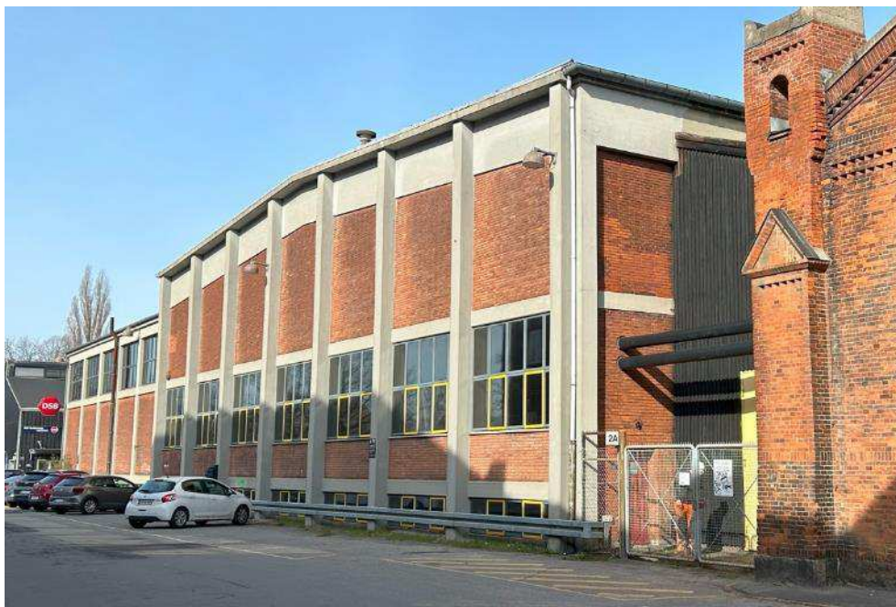
Figur 5-107 Eftersynshal. Foto COWI.
