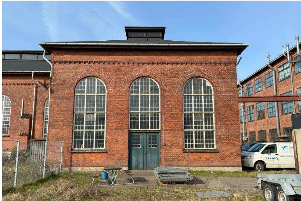
Figur 5-64 Del af kraftcentralens østlige facade. Foto COWI 2024.
