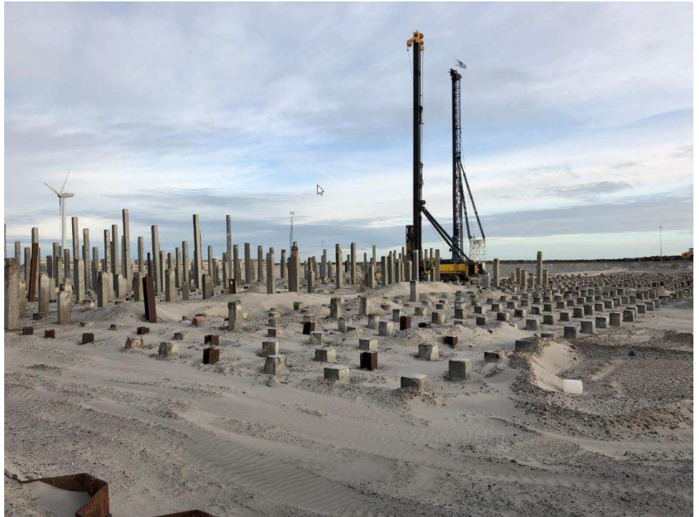
Figur 4-26 Eksempel på anlæg af pælefundering (COWI)
