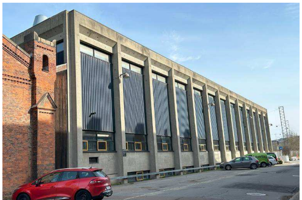
Figur 5-118 Ny eftersynshal set fra syd. Foto COWI.
