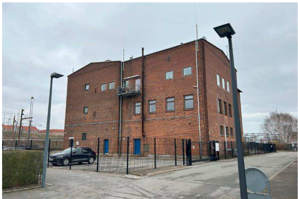
Figur 5-17 Omformerstationen set fra vest. Foto COWI 2024.
