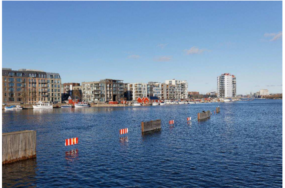
Figur 7-16 Punkt 7 – Slusen. Eksisterende forhold. (COWI)
