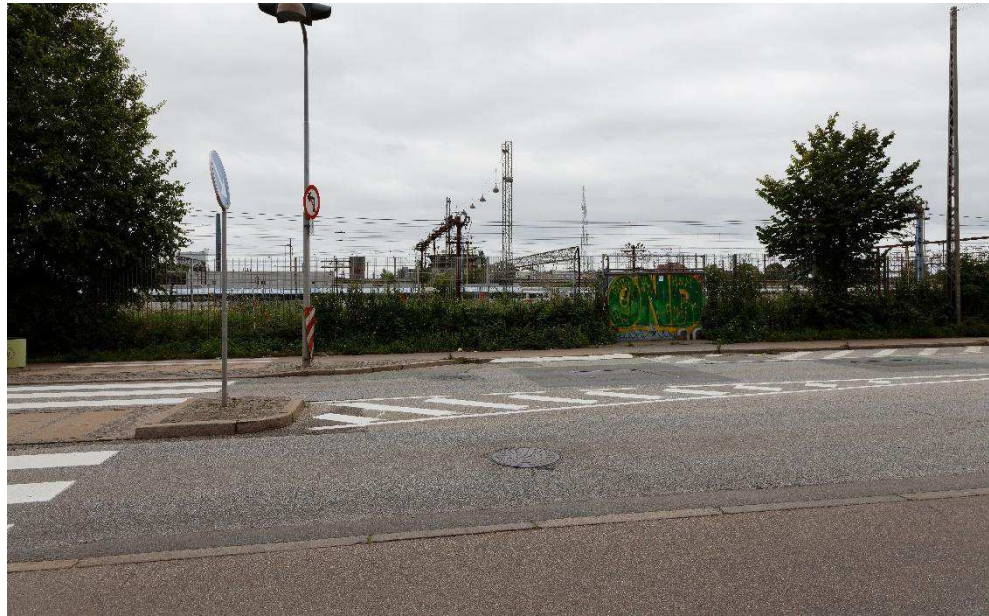
Figur 7-28 Punkt 12 – Sigerstedgade. Eksisterende forhold. (COWI)
