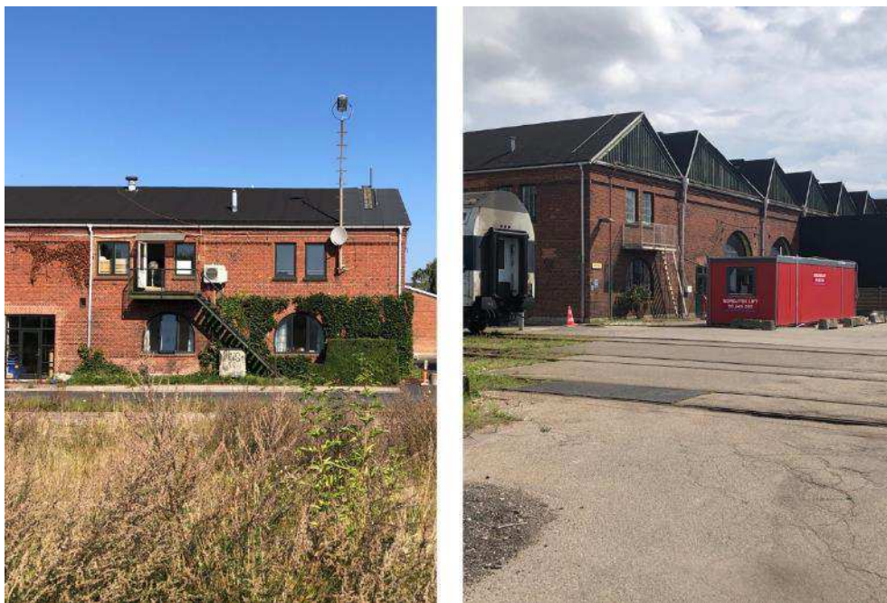
Figur 5-22 Tv. Vognværkstedets sydvestlige facade, set fra vest. Th. Vognværkstedets nordvestlige hjørne set fra vest. Foto Cobe 2023.
