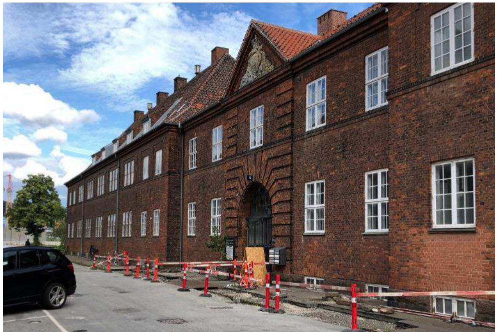
Figur 5-127 Nordfacade på Kontor- og administrationsbygningen. Foto Cobe.
