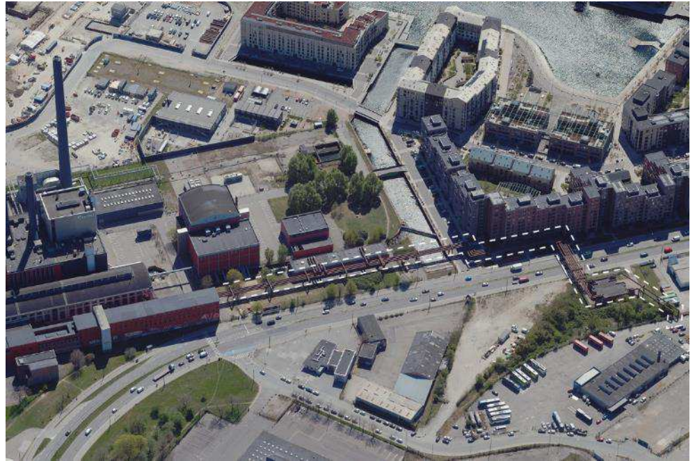
Figur 6-2 Det tekniske anlæg ved Vasbygade er markeret med en stiplede linje. En del af anlægget ligger udenfor lokalplanområdet. Illustration COWI.
