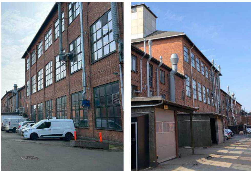
Figur 5-39 Ny elektrisk værksted. Foto Cobe.
