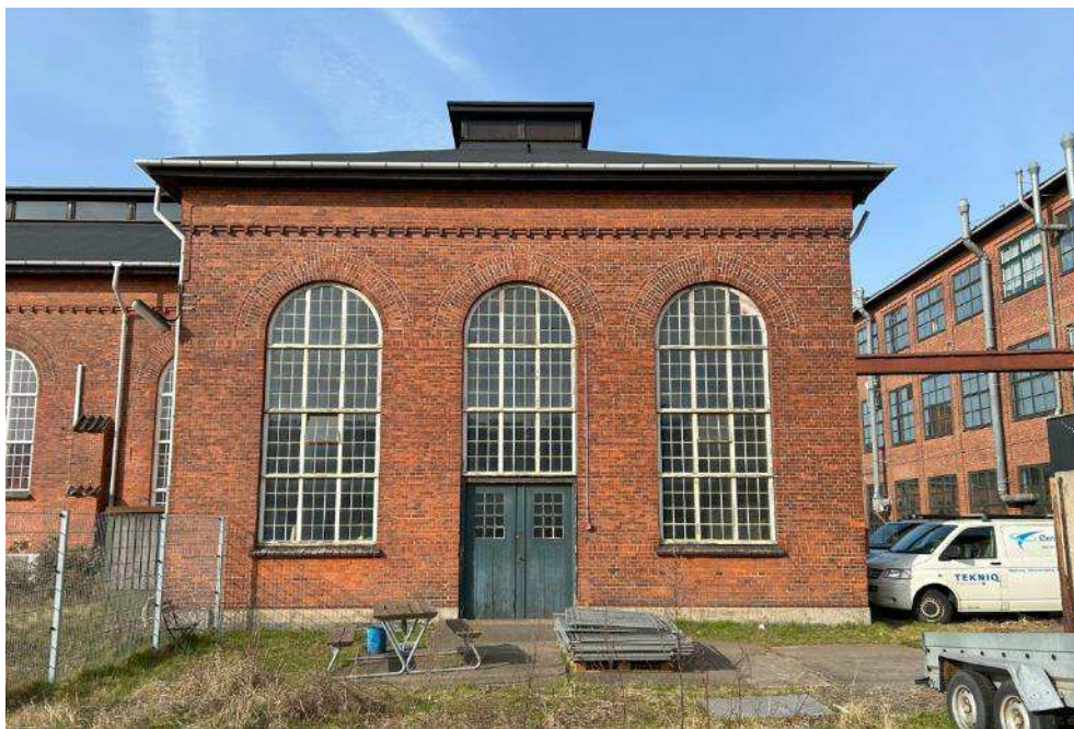
Figur 5-64 Del af kraftcentralens østlige facade. Foto COWI 2024.
