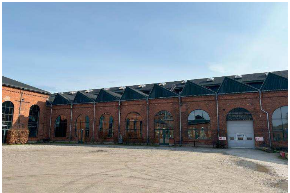
Figur 5-87 Lokomotivværkstedets facade set fra vest. Foto COWI.
