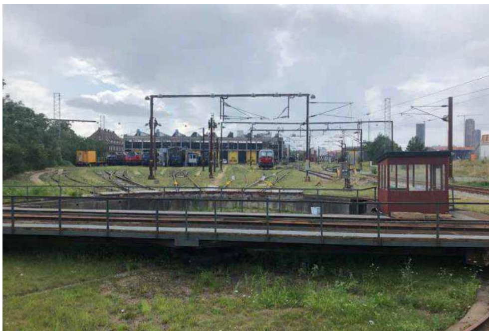
Figur 6-15 Drejeskiveanlægget set fra Carsten Niebuhrs Gade.
