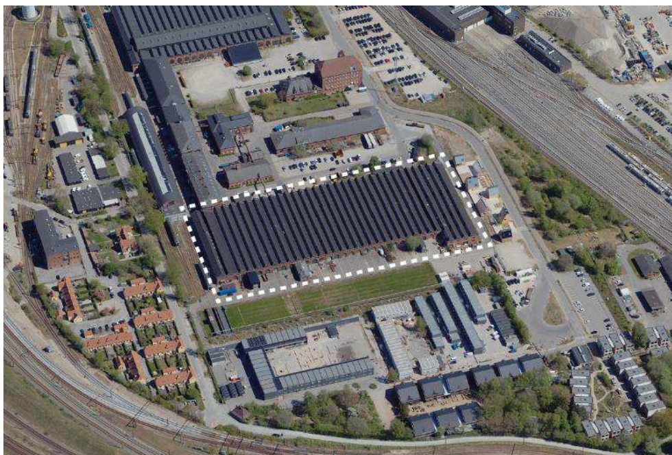
Figur 5-19 Vognværkstedet set fra vest. Den samlede bygning måler næsten 200 meter fra nord til syd. Vognværkstedet er mere end 70 meter bred. Illustration COWI 2024.
