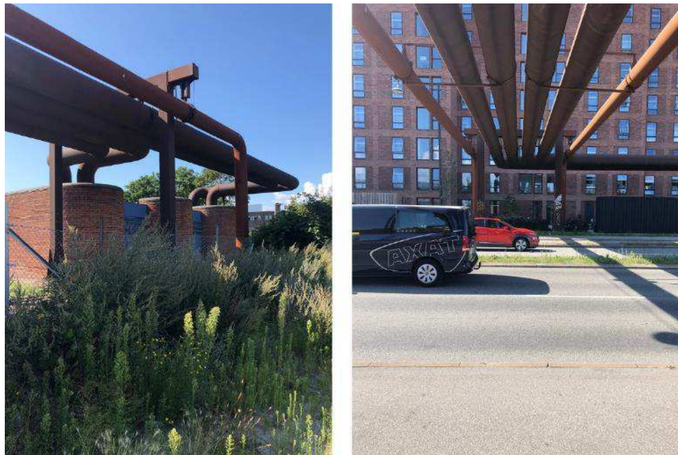
Figur 6-4 Tv. Det tekniske anlægs facader og rør mod øst. Th. de rustrøde rør hen over Vasbygade. Foto Cobe.
