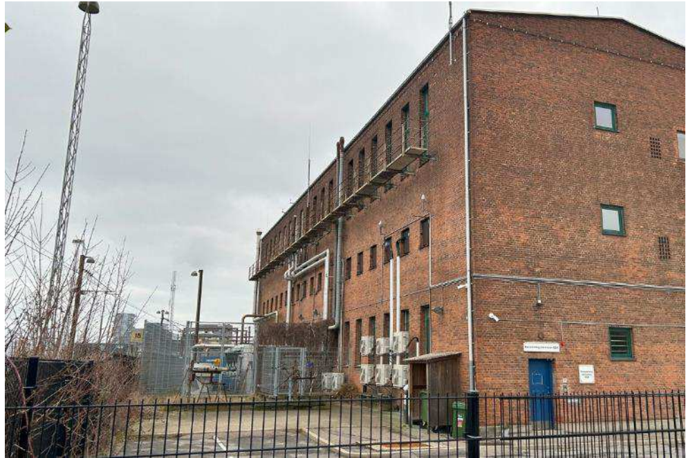
Figur 5-16 Omformerstationens bagside mod jernbaneterrænet, som ligger nord for bygningen. Foto COWI 2024.
