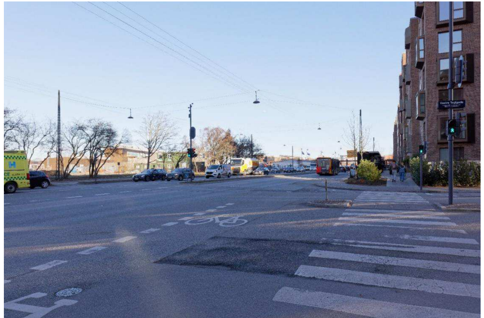
Figur 7-23 Punkt 9 – Vasbygade v. Vestre Teglade – eksisterende forhold
