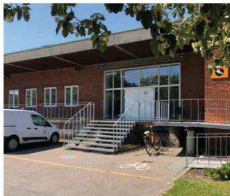
Figur 5-130 Toldkammerets facader er i røde flensborgsten. Fotos Cobe.
