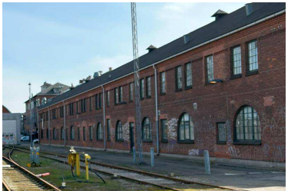
Figur 5-21 Vognværkstedets nordligste facade set fra vest. Foto COWI 2024.
