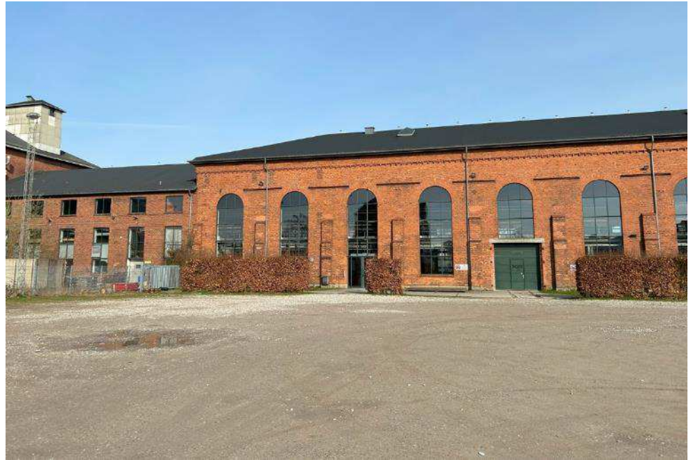
Figur 5-48 Plade- og kedelsmedjens facade set fra syd. Billedet viser, hvordan Plade- og kedelsmedjen og Kølerværkstedets facader mødes. Foto COWI 2024.
