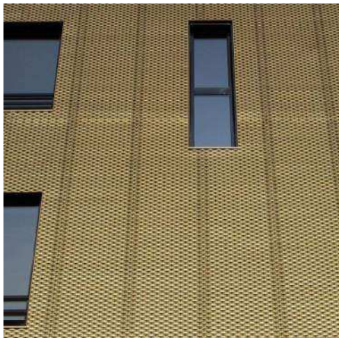
Figur 7-6 Eksempel på perforeret stålfacade med absorbent bagved.
