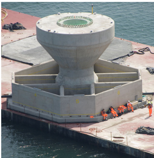
Figur 5.8 Fundament til en 2,3 MW vindmølle ved Rødsand.
