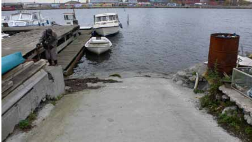
Eksisterende sliske i betonkanten
