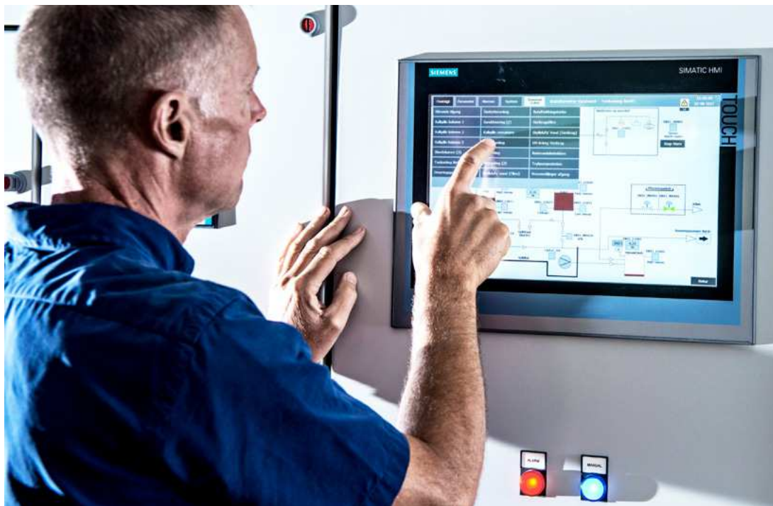
En HOFOR-medarbejder overvåger produktionen på Brøndbyvester Vandværk.
