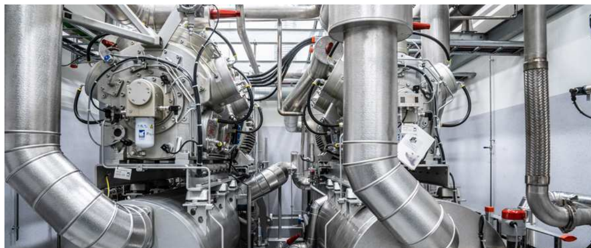
Varmepumpen ved Novozymes, der sender overskudsvarme ud i fjernvarmenettet
