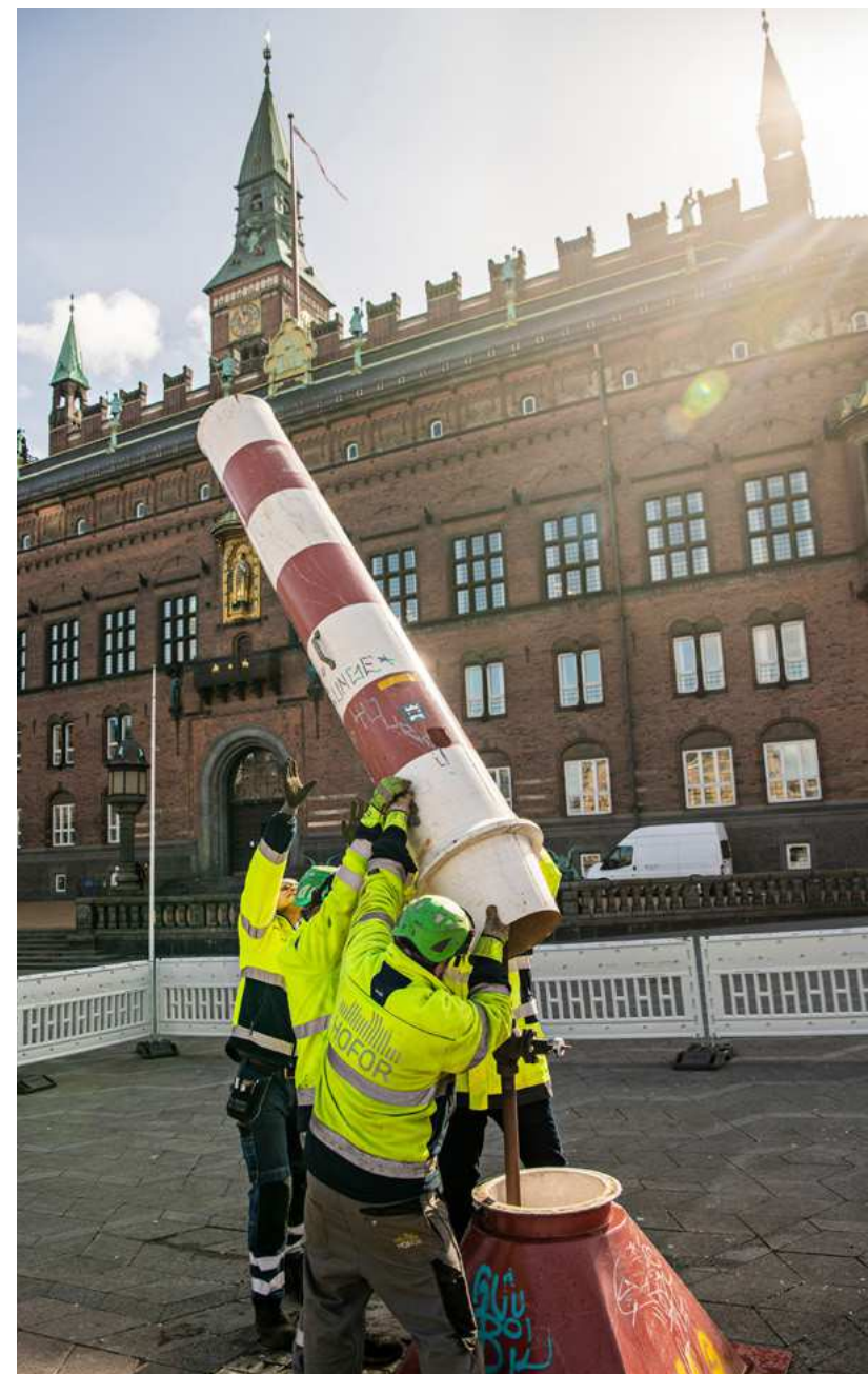
En dampskorsten fjernes fra Rådhuspladsen i forbindelse med afslutningen på konverteringen af dampnettet
