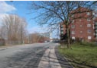
Rovsingsgade set mod nordøst. En del af DSB-grunden ses ved træerne til venstre i billedet.
