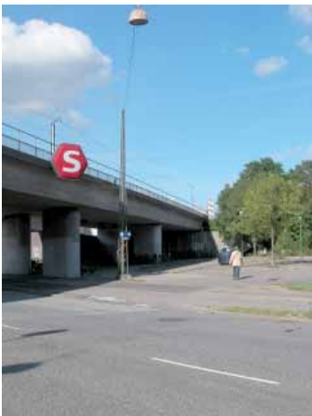
Ryparken station ligger overfor Beauvaisgrunden - på den anden side af Lyngbyvej - og er med til at give kvarteret en god trafikal opkobling.
