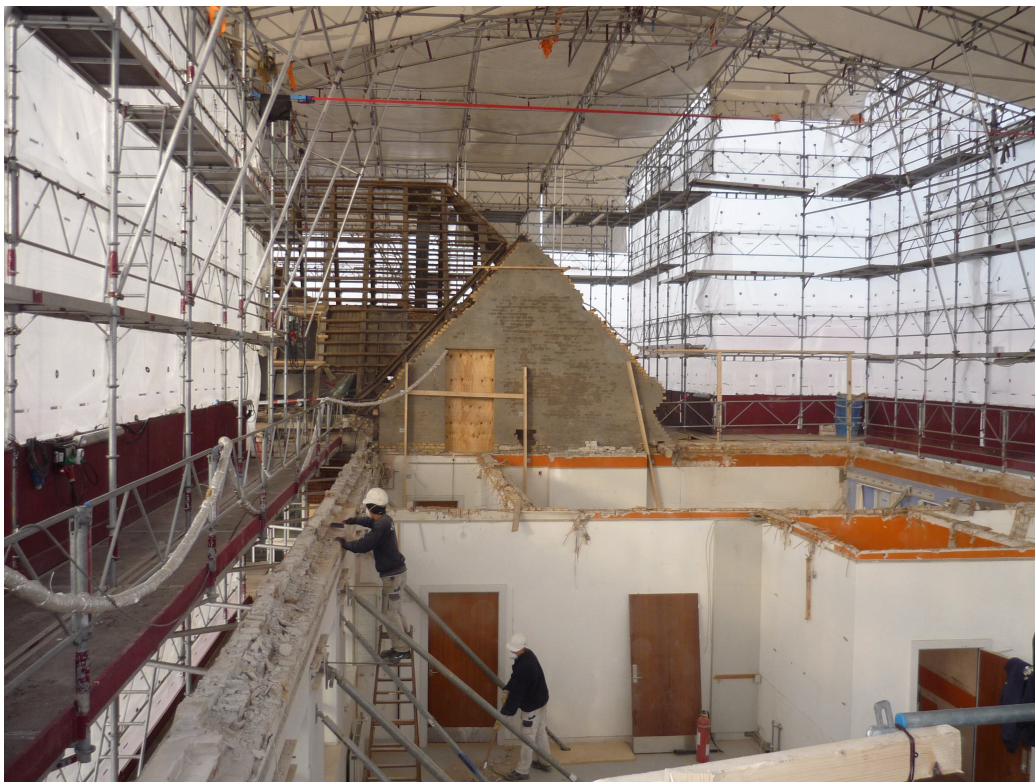
Tag på den østlige del af Sundparkbygningen. Konstruktioner og etagedæk er fjernet.
