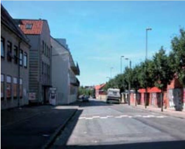
Dortheavej set mod vest med lokalplanområdet til højre i billedet. I forgrunden til venstre i billedet ses Kulturhuset og det nye Ungdomshus på Dortheavej 61.
