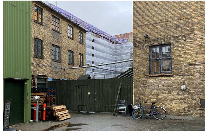
Kig fra gårdrummet. Hannovergade 8B til venstre.
